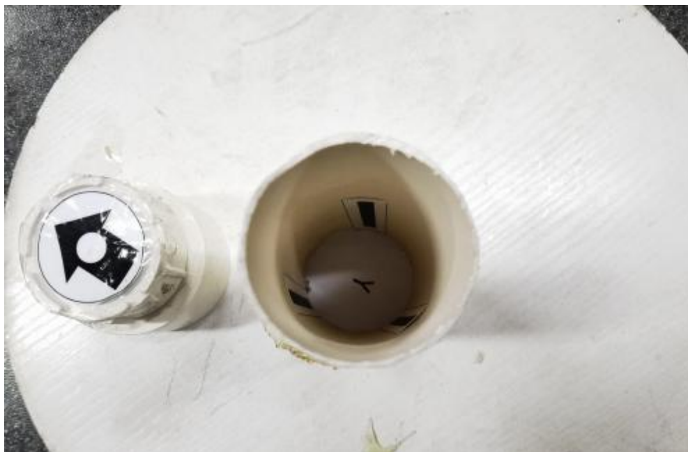
图 3 管道内部情况
